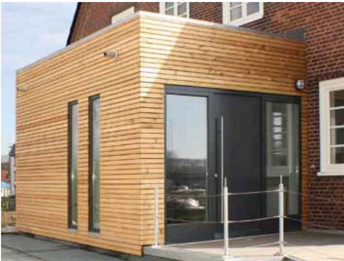
Holzanbau an ein Bestandsgebäude
