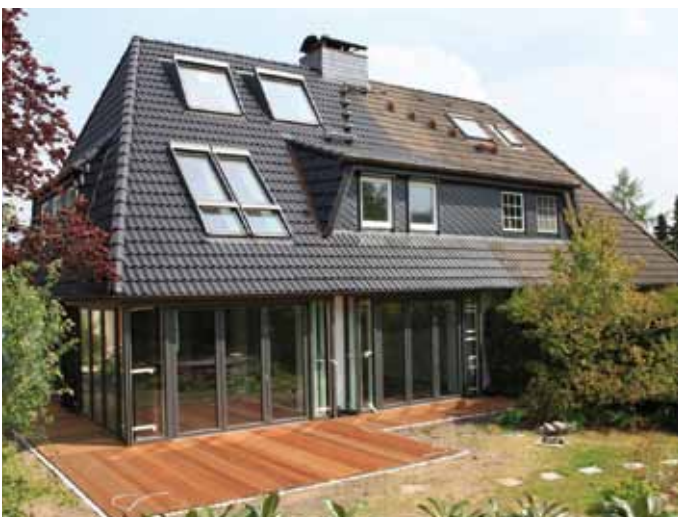
Umgestaltung einer DHH
