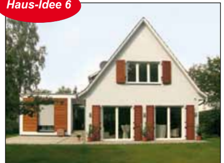
An- und Umbauten
