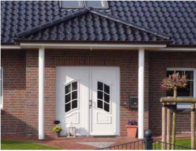
Hauseingang auf Holzsäulen
