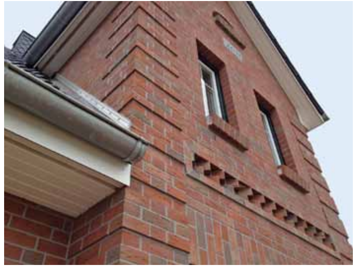
Abgesetzte Mauerwerksbossen mit Zierfries
