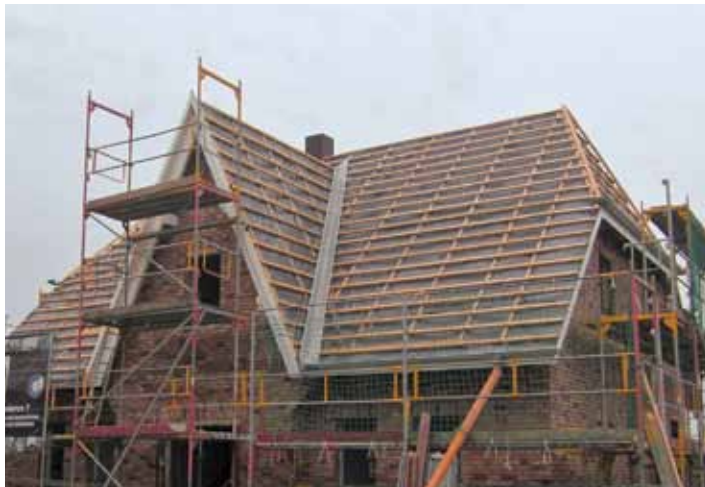
„Unterspannbahn fertig, Rinnen und Kehlen fertig, kurz vor Eindeckung.“
