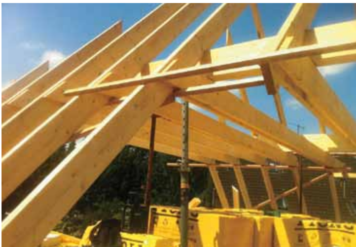
„Dachstuhl aus KVH, auf der Baustelle abgebunden“
