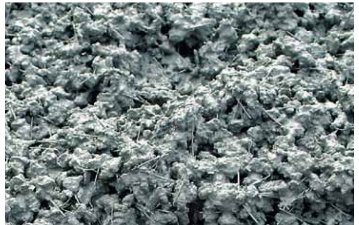
„Hier kann man gut die Stahlfasern erkennen.“
