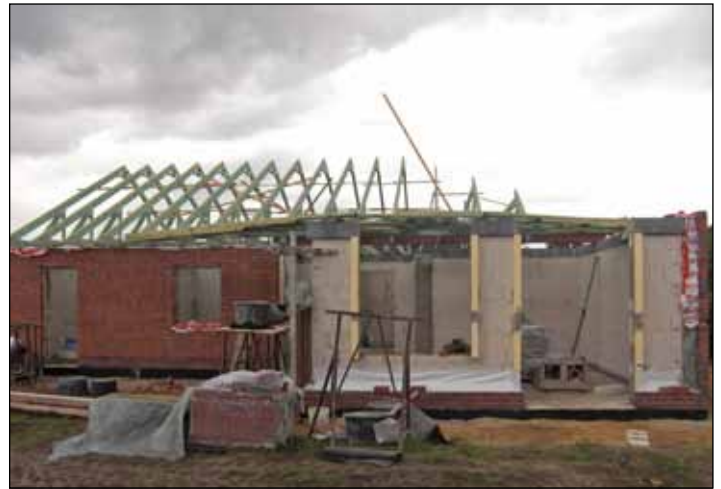
„Dachstuhl als Binderdach“
