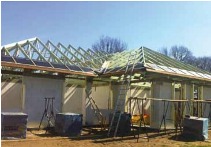
„Dachstuhl als Binderdach“
