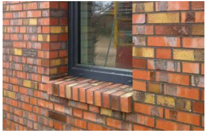
... oder als gemauerte Sohlbank ...“
