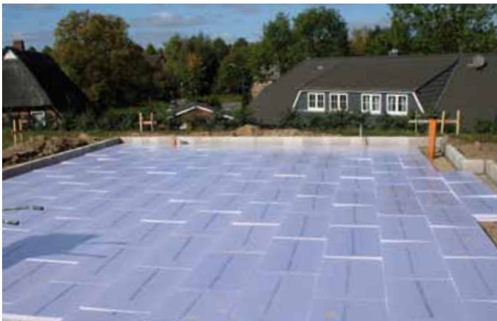
„Die Untersohlendämmung wird mit Stufenfalz verlegt.“
