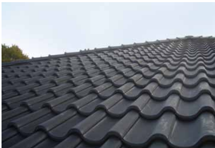
... Eindeckung mittels Tondachsteinen ...
